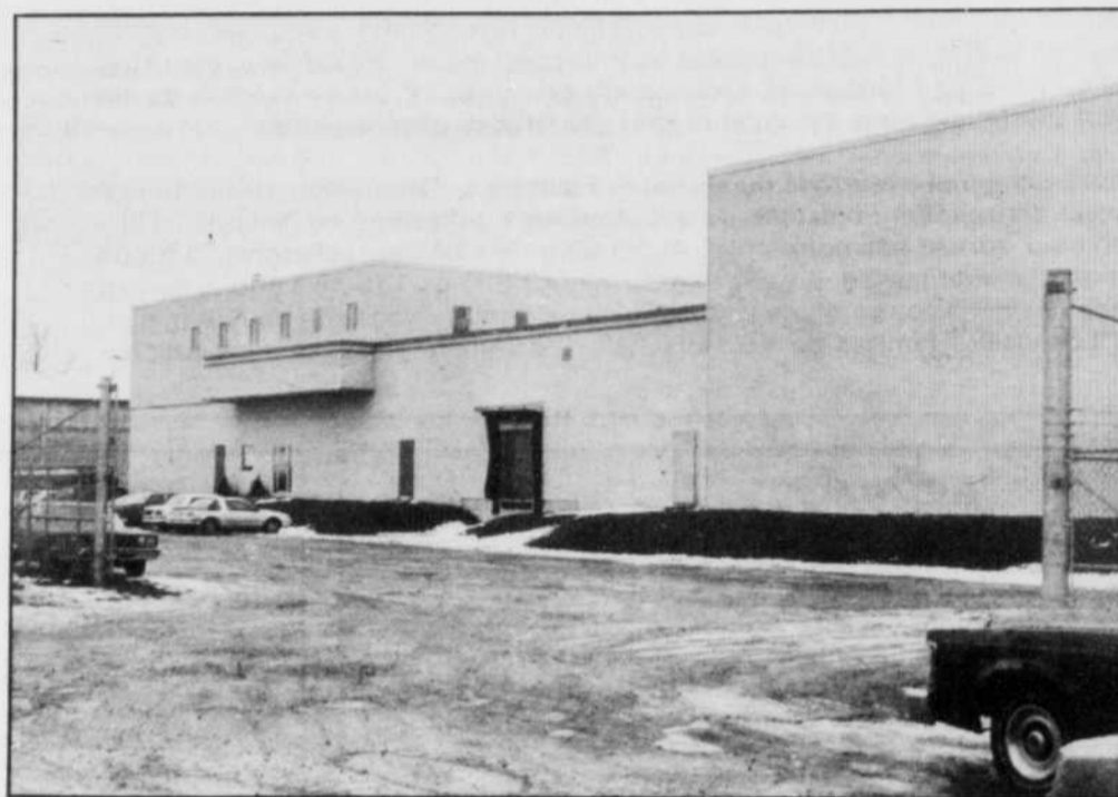
La nouvelle usine que Cofranca occupe depuis près d'un an maintenant.
