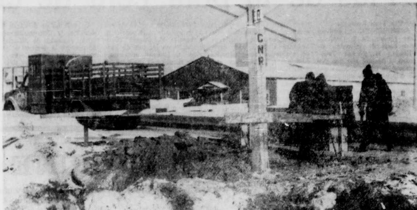
Une équipe de la compagnie des chemins de fer nationaux travaille à installer un système de sécurité lumineux à la traverse de la rue Labbé, dans le parc industriel. Ces travaux avaient été demandés par la ville. (Photo La Tribune, Victoriaville)
