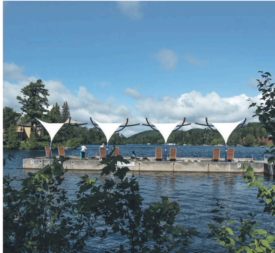
Le haut niveau de l'eau au printemps a retardé le chantier du quai d'environ deux semaines, mais les travaux au quai municipal sont maintenant exécutés. Des cours de yoga y sont notamment offerts. (Photo
