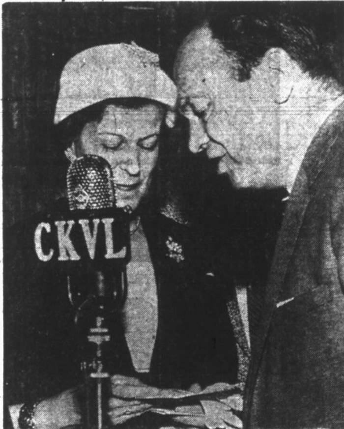
Mme Maurice Reid, 3815 ouest, boulevard Gouin, reçoit de Marcel Beaugard, chef des nouvelles à CKVL, un chèque de $850, pour avoir téléphoné la meilleure nouvelle au cours de 1958, soit l'effondrement d'un caisson du pont de l'autoroute alors en construction sur la Rivière des Prairies. Ce drame a coûté la vie à 11 personnes. Le jury était composé du directeur Hilaire Beaugard, de la Sûreté provinciale, du directeur Albert Langlois, de la police de Montréal, du directeur Pierre Gatineau, de la police de Verdun, de Christian Verdon, chef de l'information à Montréal-Matin et Jacques Francoeur, co-propriétaire de Dimanche-Matin.
