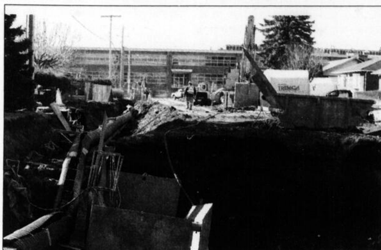
La portion du projet portant sur le boulevard Dorchester s'avère laborieuse à réaliser.
