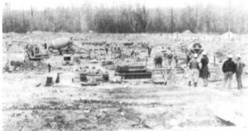
Le chantier de la turbine à gaz de Bécancour est situé sur le site de la centrale nucléaire de Gentilly 2. Le coût total du projet près de 400 000 000 $. (Photo: M.M.)
