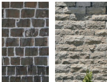
Maçonnerie de pierres
