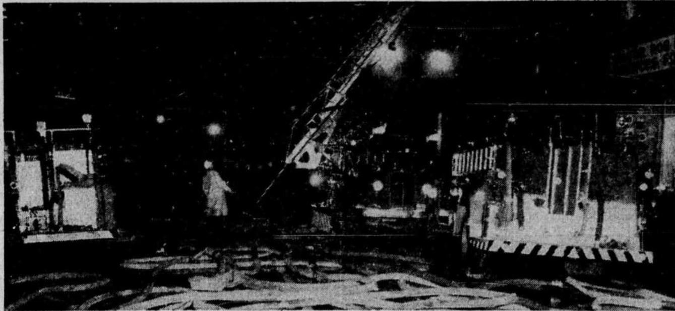
Incendie, rue Notre-Dame. — Un incendie qui a nécessité deux alarmes a détruit, samedi matin, deux immeubles de trois étages à l'angle des rues Notre-Dame et Bisson. Un restaurant et une mercerie pour hommes se trouvaient au rez-de-chaussée des immeubles. Des logements aux étages supérieurs étaient heureusement inoccupés, à cause de travaux de réparations. Cent vingt-cinq pompiers ont réussi à maîtriser les flammes après un travail de deux heures.
