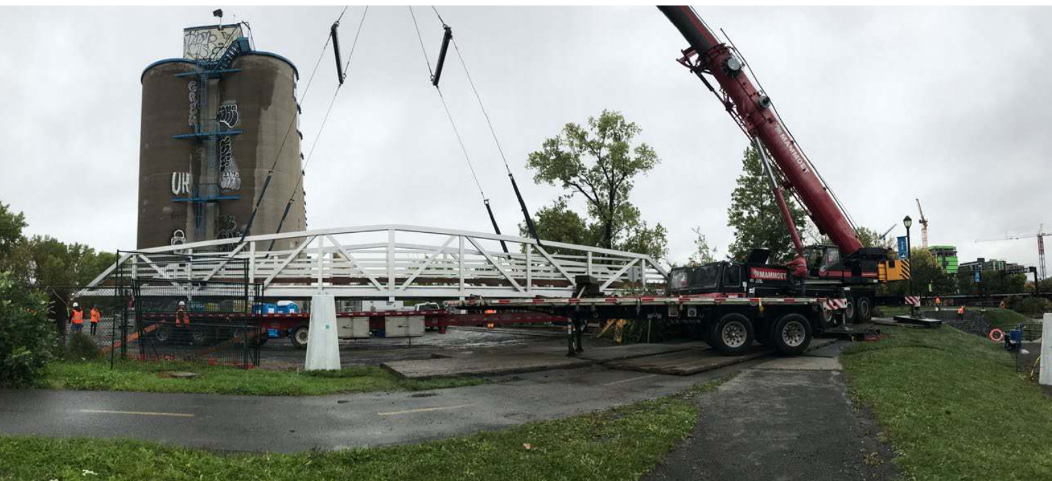
Un panorama de la nouvelle passerelle Wellington, installée en 2018. Crédit photo : Parcs Canada.
