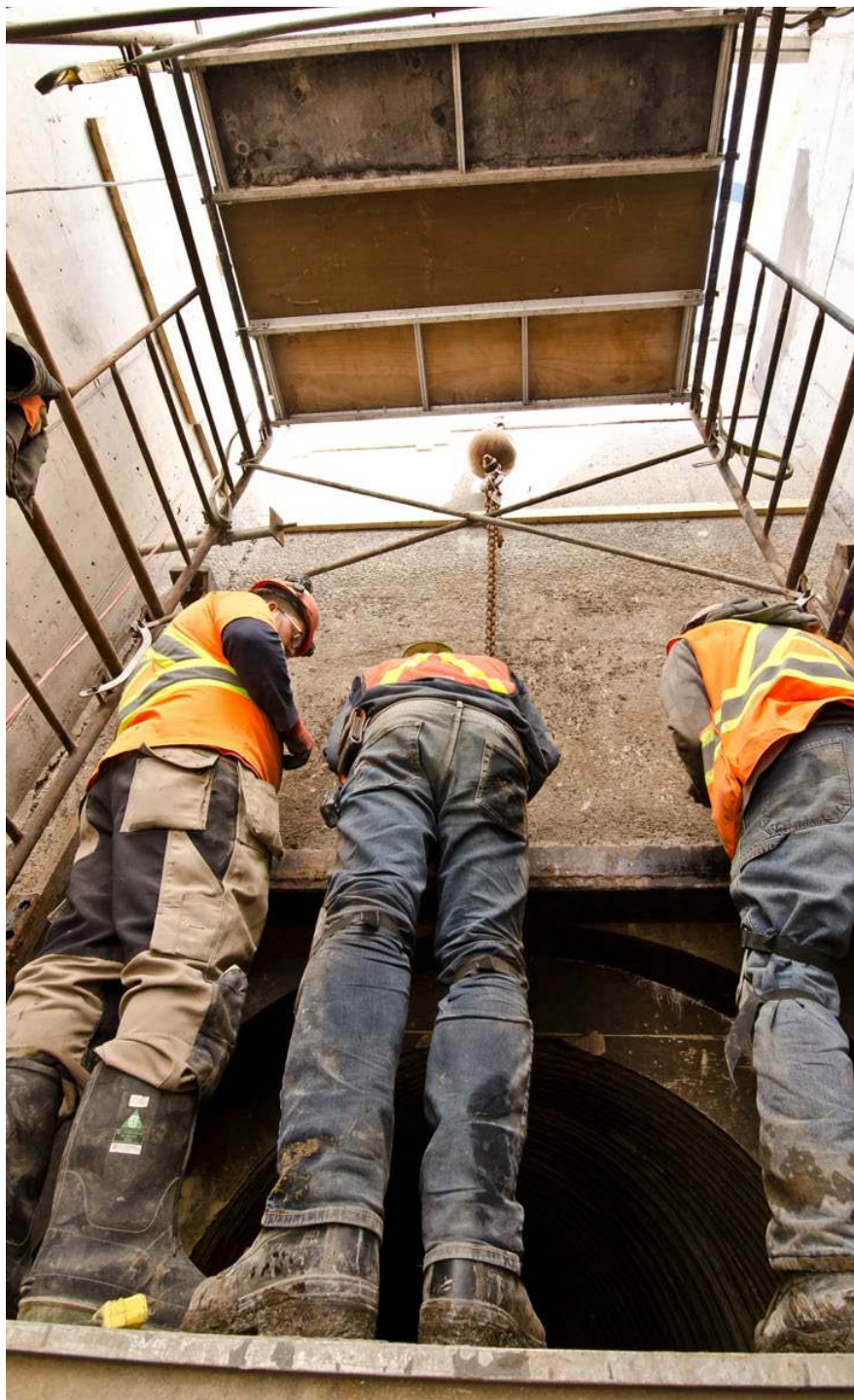
Travaux sur la prise d'eau au Canal-de-Lachine, 2016. Crédit photo : Parcs Canada.
