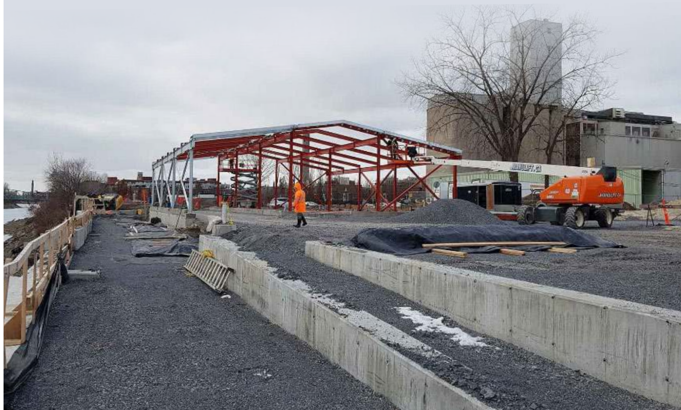
Automne 2018 : construction du Hangar 1825 . Crédit photo : Parcs Canada.
