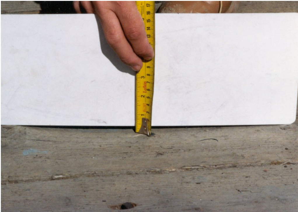
Photo 4.6-2 a) – Usure légère d'un platelage en bois
