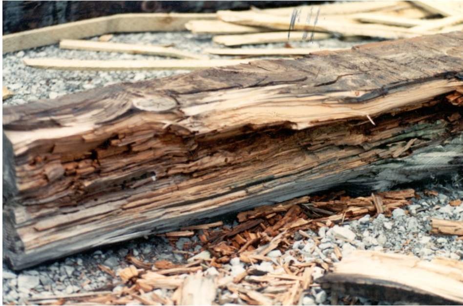
Photo 4.6-1 d) – Pourriture très importante d'une pièce
