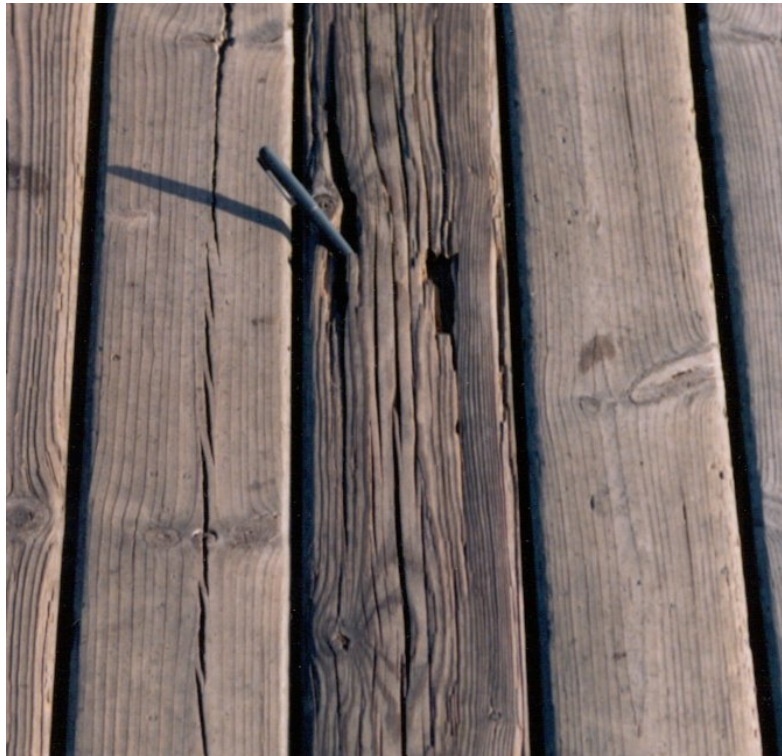
Photo 4.6-1 b) – Pourriture moyenne d'une pièce
