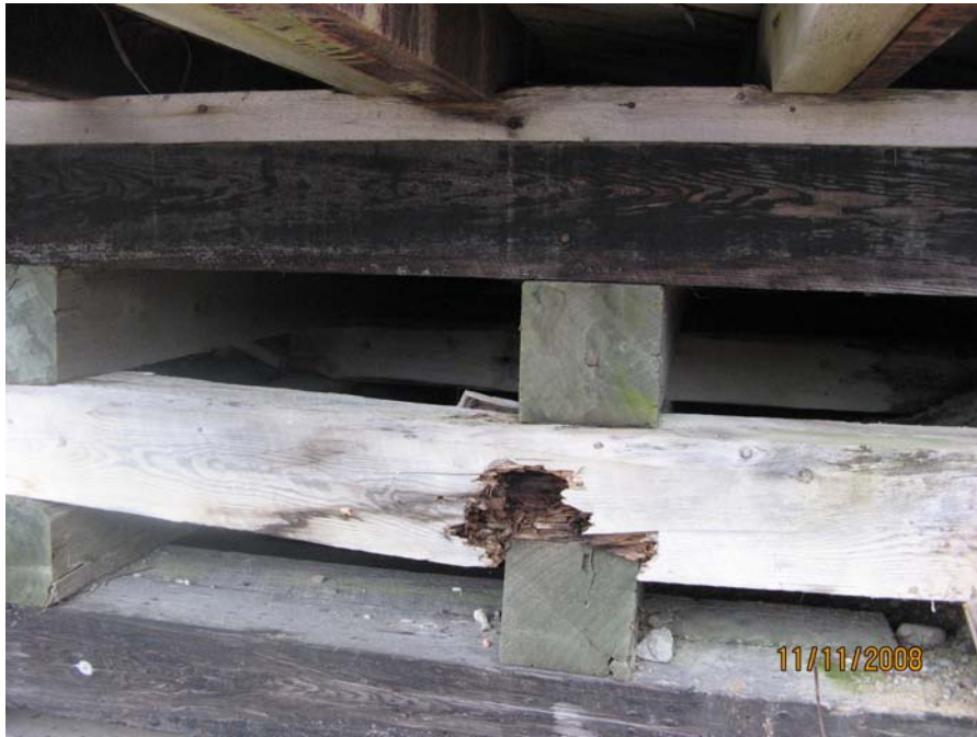
Photo 4.6-4 c) – Écrasement d'une pièce
