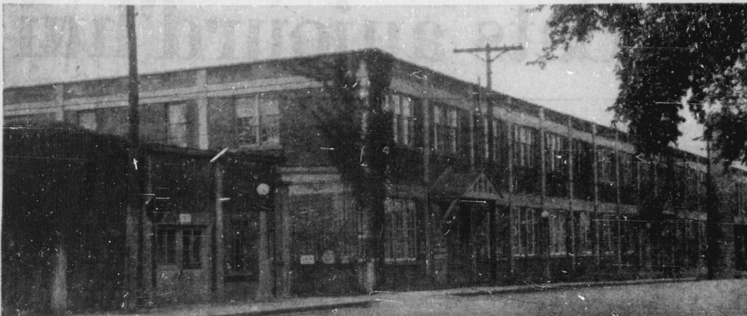
ADIEU, MOULIN EDWARDS — La démolition du vieux moulin Edwards, en bordure du Sussex Drive, a commencé hier. Il s'agit du premier de plusieurs projets de démolition d'édifi-
