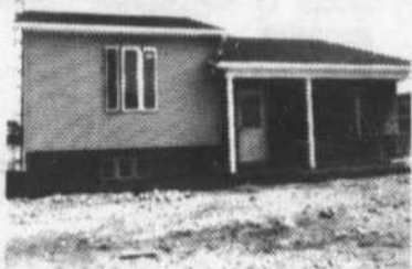
# 2518 Bungalow, construction 1987. Sous-sol semi-fini, tour antenne, intérieur très ensoleillé. Transfert, prix pour vendre. Inf.: AURÉLE BEAUREGARD 1-773-8424
