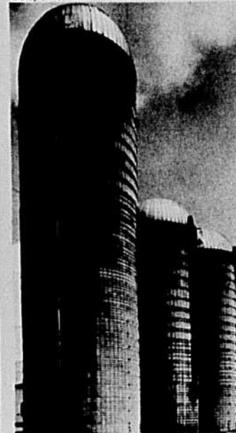
Silos en douves de béton à St-Etienne, Qué., par Dion et Frères de St-Thérèse, Qué.
