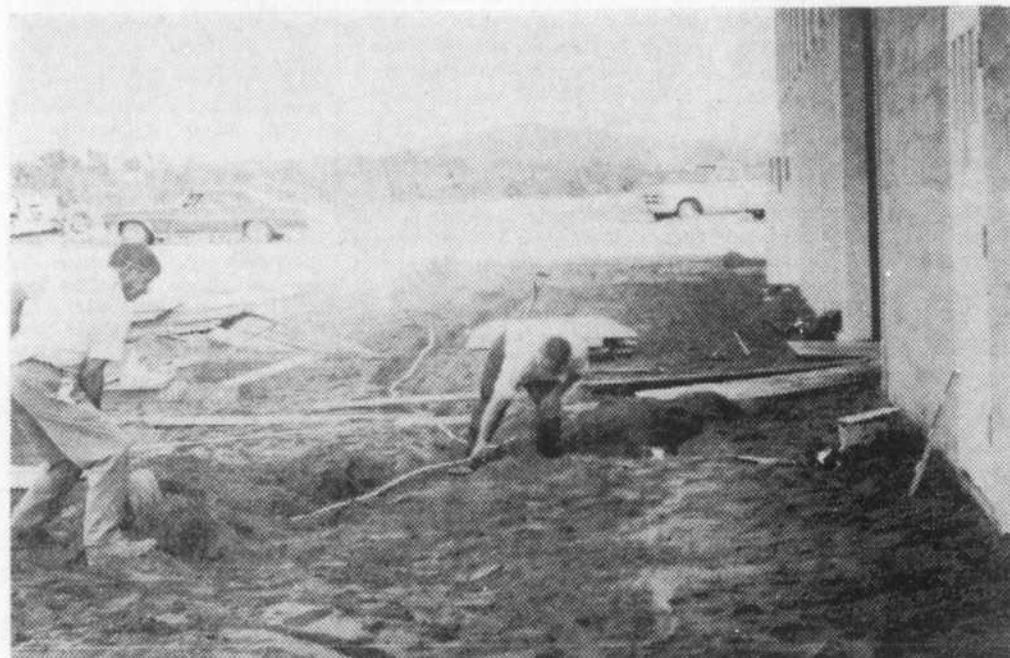
ANNEXE — L'on est à construire une annexe de 24 x 100 pieds à l'aréna de Warwick. Cette construction abritera 4 chambres de joueurs, des douches, et le système de réfrigération y seront logés. (Photo La Tribune, Victoriaville)
