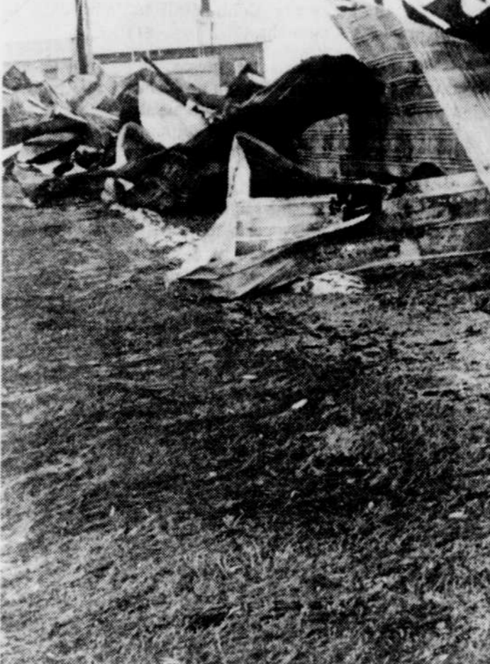
Voilà tout ce qui reste du vaste poulailler de M. B.W. Caron de Montréal qui a été détruit par les flammes tôt hier matin à l'entrée de St-Albert. La bâtisse s'est consumée en moins de deux heures. (Photo La Tribune, Victoriaville, Serge Beaucher)
