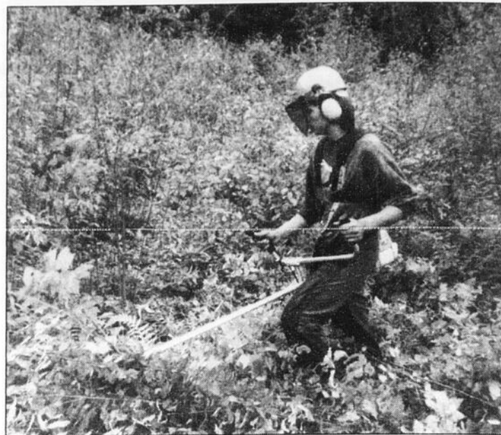
ENTRETIEN - Des travailleurs de la région réalisent présentement des travaux de nettoyage des emprises de lignes de transmission d'énergie d'Hydro-Québec.
