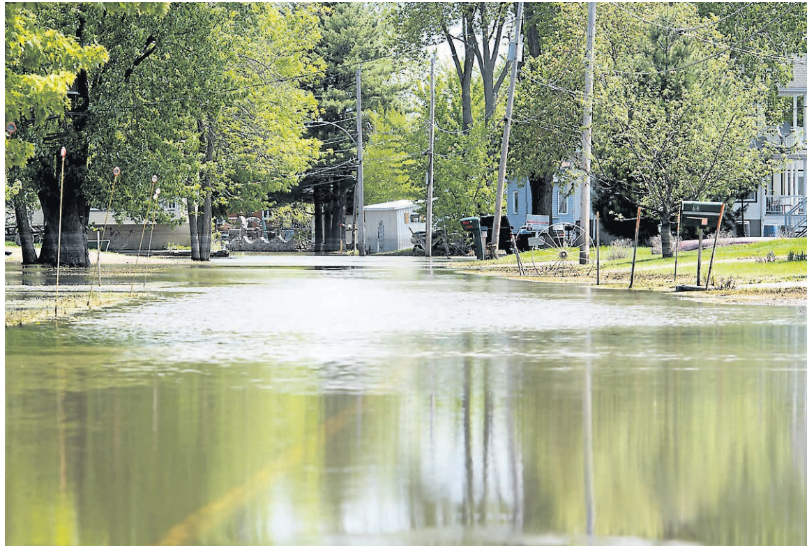
Une partie de la route Langue-de-Terre à Maskinongé est toujours couverte par une bonne quantité d'eau.
