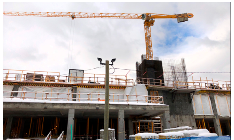
Les travaux consistent en la pose d'armature et le bétonnage des murs, des colonnes, des voûtes et des dalles structurales.
