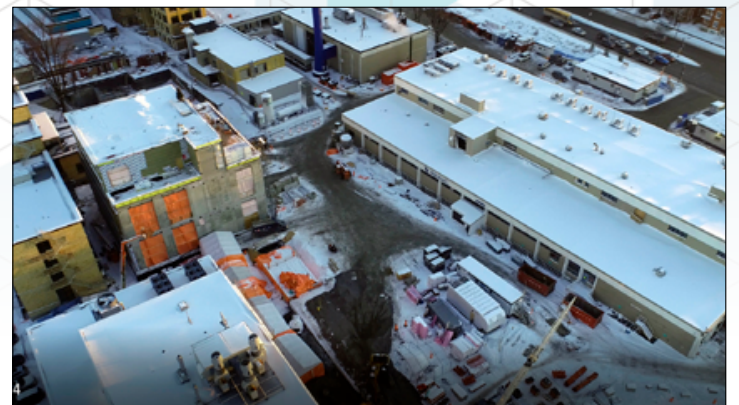
À gauche, le nouveau bâtiment des génératrices derrière le pavillon Notre-Dame (aile H) et à droite, l'ancien bâtiment de Partagec qui est présentement en démolition.
