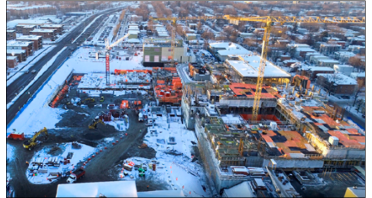
Vue aérienne du chantier. À gauche, les travaux d'excavation et d'installation des structures du stationnement souterrain.
