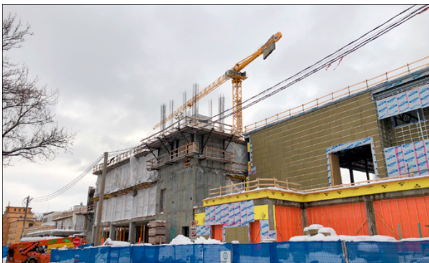
Vue de l'avancement des travaux du CIC depuis l'avenue de Vitry.
