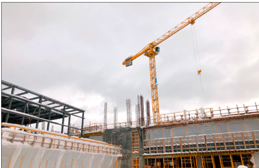
Les travaux nécessaires à la réalisation du NCH demandent des équipements lourds, tels que des grues à tour. Il y en a actuellement quatre en fonction sur le chantier.
