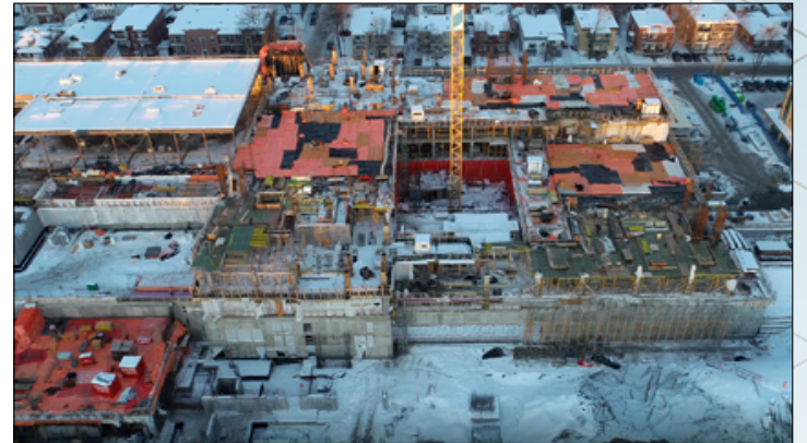
Vue aérienne des travaux de construction du CIC.
