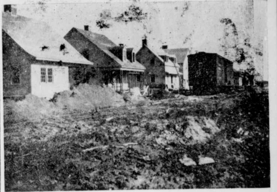
Voici l'aspect que présentait, il y a quelque vingt ans, ce qui est aujourd'hui la rue Davy. La Compagnie de construction avait installé des voies ferrées dans la plupart des rues afin de transporter les matériaux avec plus de facilité.
