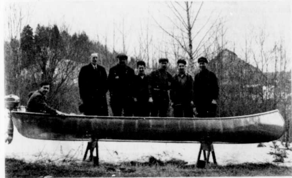
Photographie démontrant la résistance du canot en aluminium "fréteur". Scutenu par ses seules extrémités, il porte sans fléchir, le poids de sept hommes. On reconnaît de gauche à droite: MM. J.-C. Tremblay, R. Bélanger, propriétaire des Canots d'Aluminium du Saguenay, E. Blanchette, M. Pedneault, L.-P. Basque, R. Pedneault et A. Basque. Ces personnes font un poids total de 1,100 livres.
