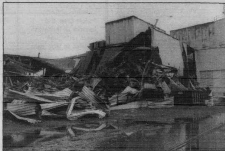
Il faudra environ un mois pour nettoyer les décombres de l'ancienne Fonderie Unique, détruite par le feu à la mi-avril.
