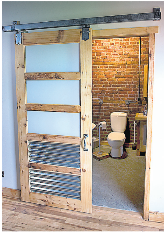
PHOTO ALAIN ROBERGE, LA PRESSE © Cette porte est faite de restants de tôle ondulée et de verre récupéré des anciennes fenêtres du triplex. Ce verre a été opacifié.
