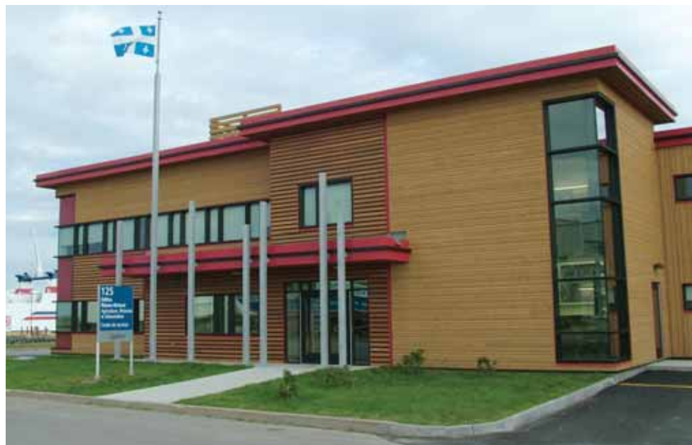
L'usine de fabrication de glace fait partie du bâtiment qui regroupe les services du ministère de l'Agriculture, des Pêcheries et de l'Alimentation aux Îles-de-la-Madeleine.
