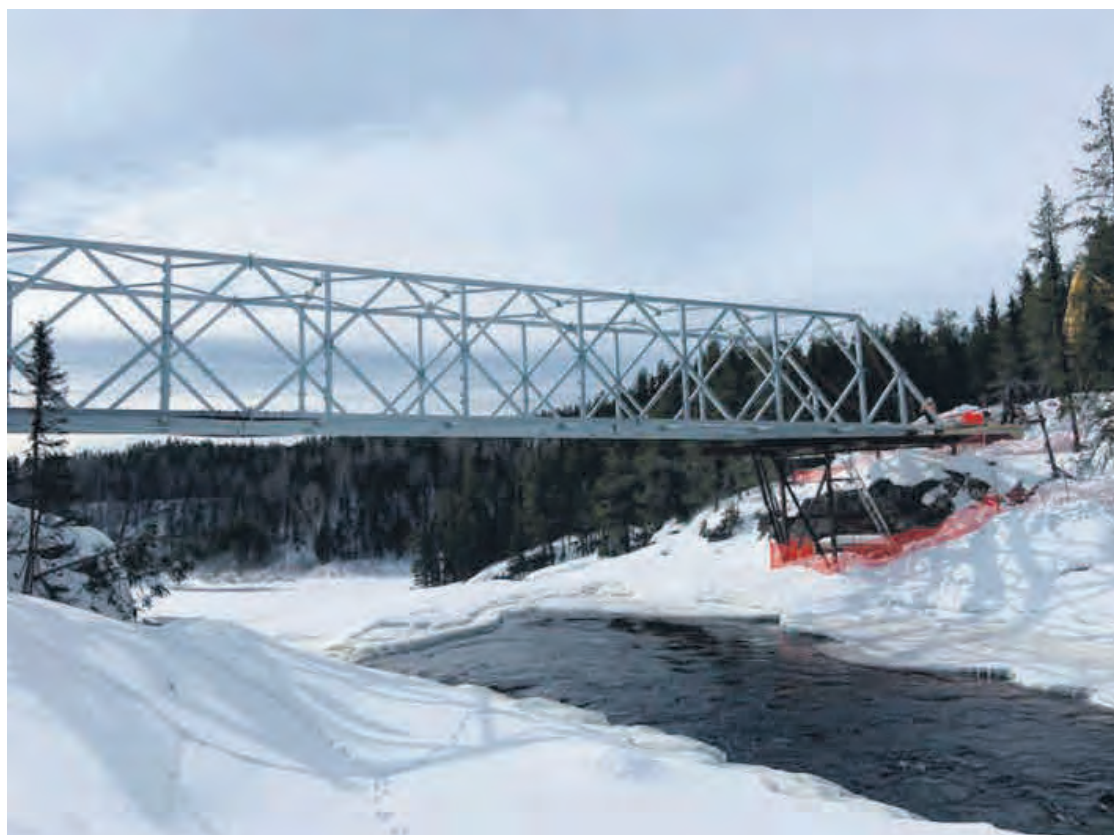
La passerelle pour véhicules hors route sur la rivière du Sault aux Cochons a été installée d'une rive à l'autre la semaine dernière. Une inauguration officielle est en préparation. Photo courtoisie
