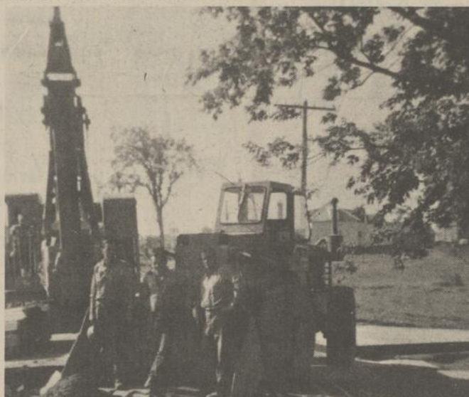
LES TRAVAUX D'AQUEDUC, qui ont été effectués dernièrement à Upton, n'ont fait que rendre plus adéquat le système d'eau du village. Ces réparations aideront également à la protection des citoyens car en même temps on y a installé plusieurs bornes-fontaines.
