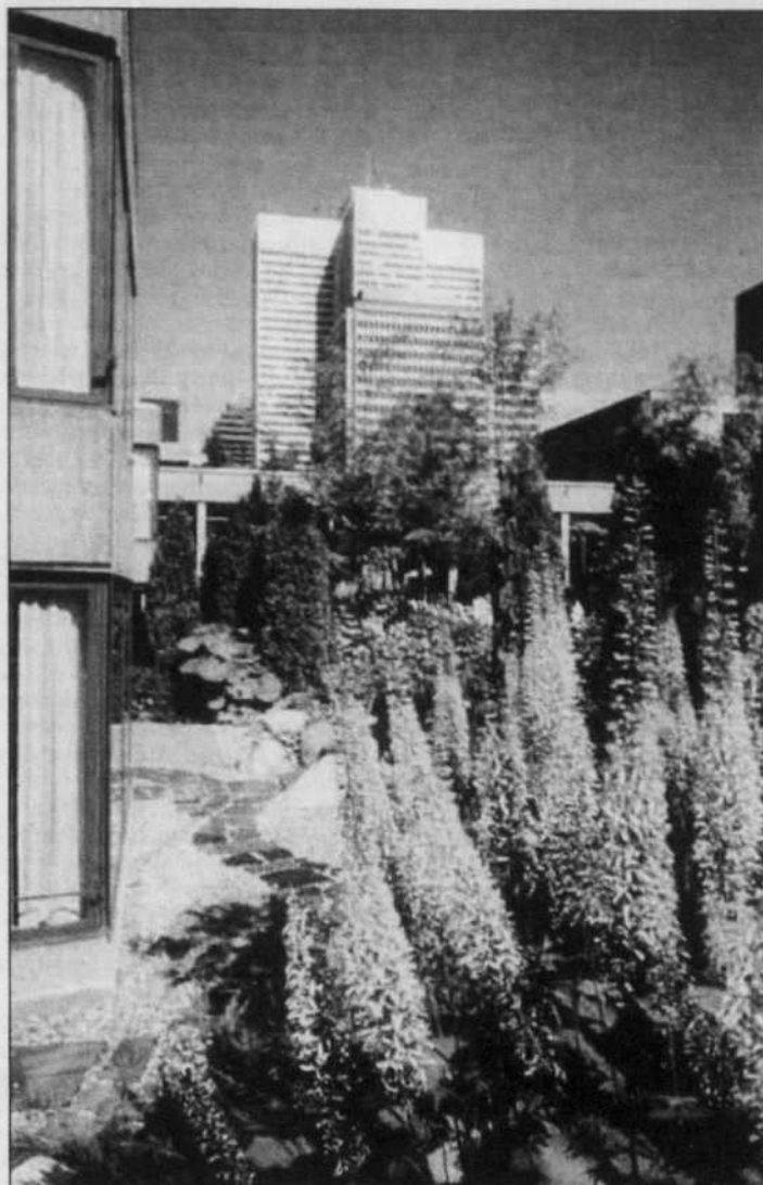
AMÉNAGEMENT CÔTÉ JARDIN L'usage des toits végétaux est assez répandu sur des édifices publics. Le toit-terrasse de la Place Bonaventure faisait figure de pionnier lors de son inauguration. L'édifice de Loto-Québec est aussi doté d'un toit-terrasse.
