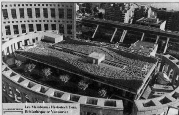
LES MEMBRANES HYDROTECH L'usage des toits végétaux est assez répandu sur des édifices publics comme la bibliothèque de Vancouver. Au Québec, la bibliothèque de Châteauguay et l'édifice de la Mountain Equipment Co-op seront dotés de toits végétaux.
