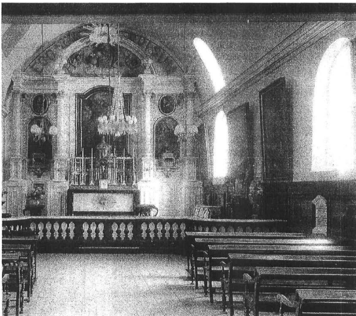
Figure 18 (rép. no 12) : Vue de l'intérieur de l'église Notre-Dame des Anges en 1934 (détail).
