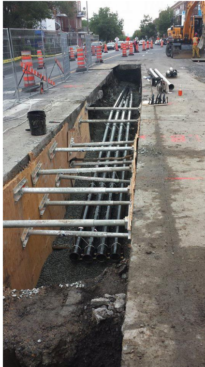
Photo 2 : Étançonnement des parois de la tranchée
