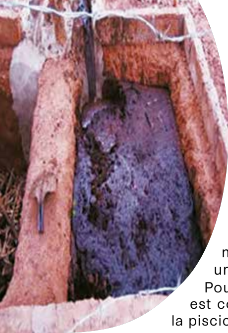
Figure 7. Fosse à compost biodigesteur
