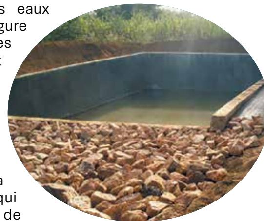
Figure 6. Bassin de collecte des eaux de ruissellement du Centre de formation agricole et artisanale de Tangaye Source : AFDR, 2017
