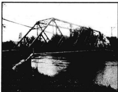
La Ville de Huntingdon a annoncé que les travaux de réfection du pont Walker seront réalisés au coût de 150 000 $ à compter du mois d'août pour se terminer avant l'hiver 1998. (Photo : H.T.)
