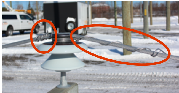
Relâchement des fils d'attache
