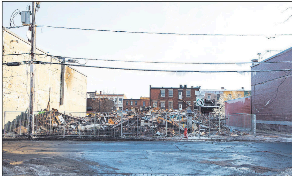
C'est tout ce qui reste des deux immeubles de la rue Champlain qui ont été incendiés en début de semaine. Celui de gauche était désaffecté depuis un an, l'autre logeait le cabinet médical du Dr Jacques Brosseau.
