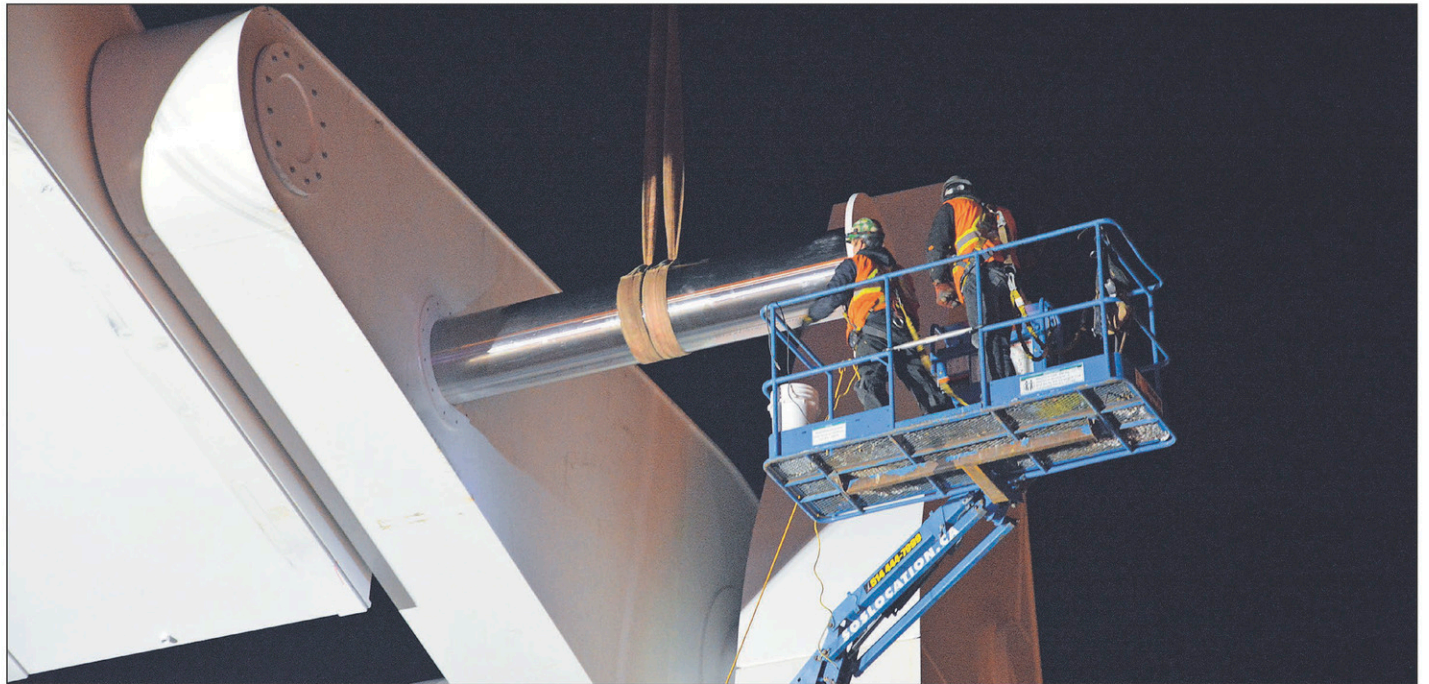
L'étape laborieuse a été d'insérer les cylindres qui maintiennent le contrepois aux bras. Commencée en après-midi, cette manœuvre s'est étirée bien après la tombée du jour.
