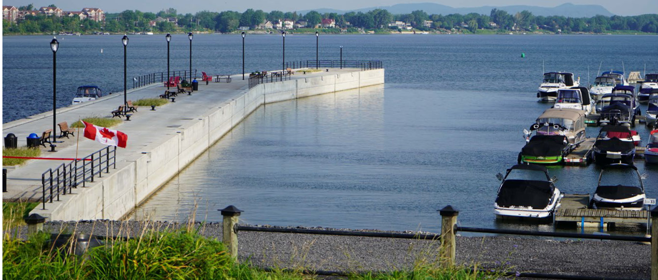
Nouvelle jetée au Canal-de-Chambly. Crédit photo : Parcs Canada.
