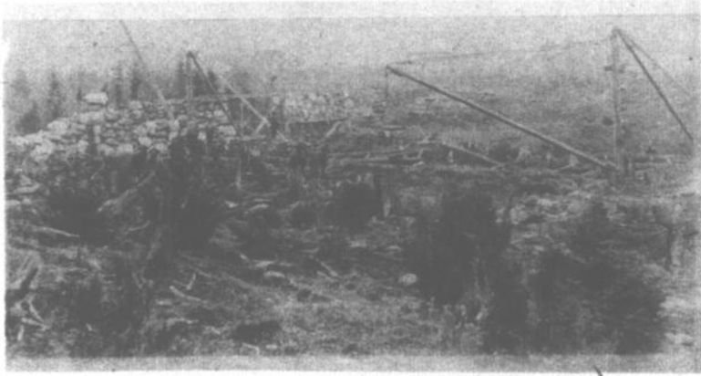
Nous apercevons une équipe au travail dirigée par M. Pit Philius Bureau au cours de la construction du barrage; on se servait de palans montés sur des mats pour déplacer les grosses pierres, et enlever les souches.
