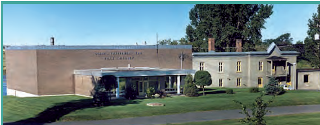
Usine de traitement de l'eau dans les années 1970 - courtoisie Ville de Nicolet
