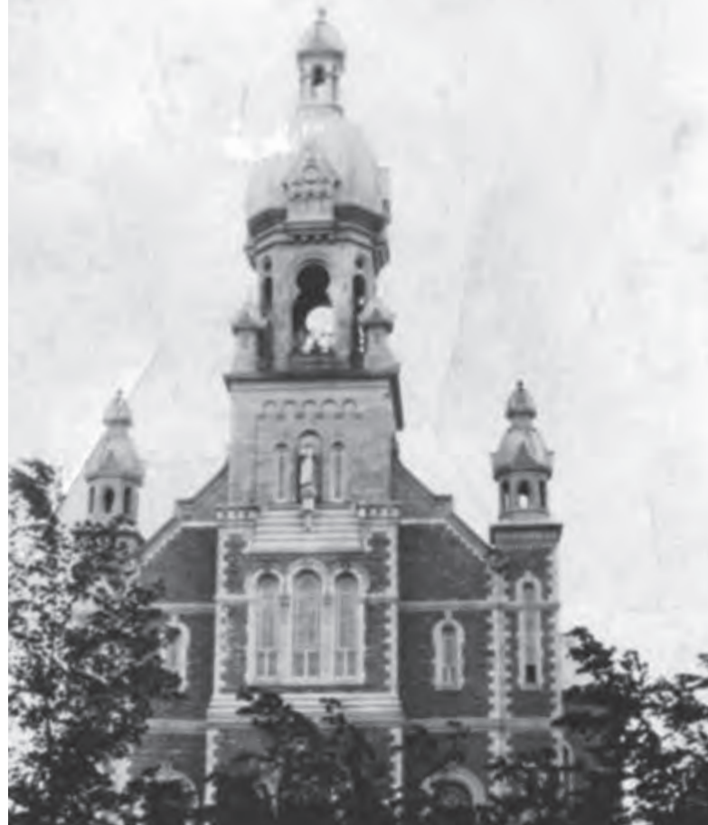
Église de Baie-du-Febvre - 1899-1904 - BAnQ_P748S1P1142
