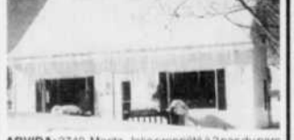
ARVIDA: 2740, Montz. Jolie propriété à 2 pas du parc Montz, plancher de bois sur 2 étages, secteur tranquille, 68 900 $ négociable. Inf.: Gilles Côté, 549-0816 ou 545-1515.
