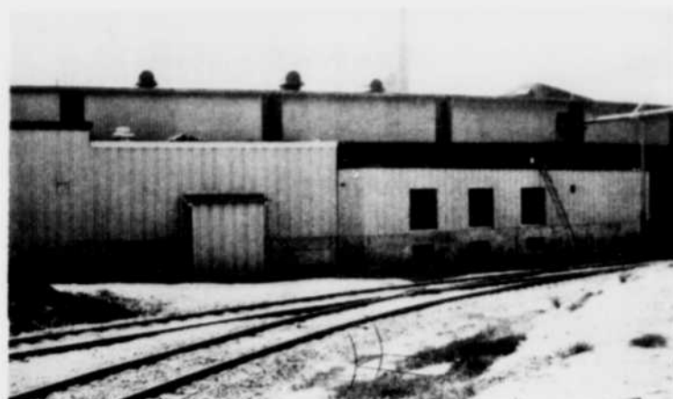
L'atelier de réparation des wagons du RS est maintenant annexé de bureaux qui promettent d'être fonctionnels et adéquats. Au cours des prochaines semaines, le tout sera complété.
