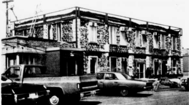
Un nouveau revêtement d'aluminium viendra redonner un air de modernisme et de propreté à l'édifice du Roberval-Saguenay à Arvida. Une histoire à suivre...
