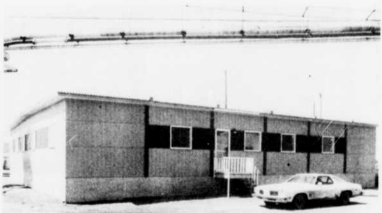
La bâtisse 400, une fois les 6 modules assemblés.
