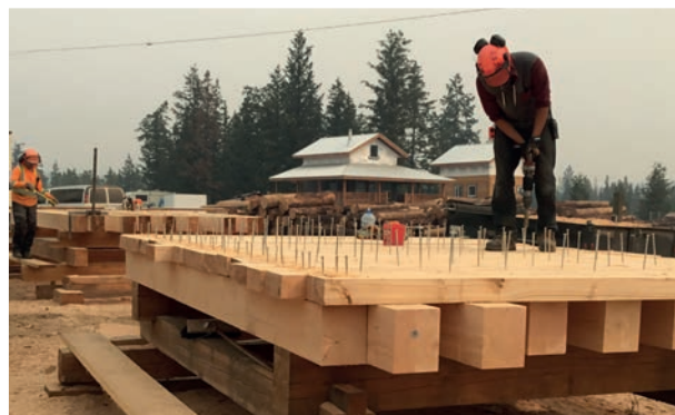
Assemblage par l'équipe Toosey des composants du tablier du pont.
