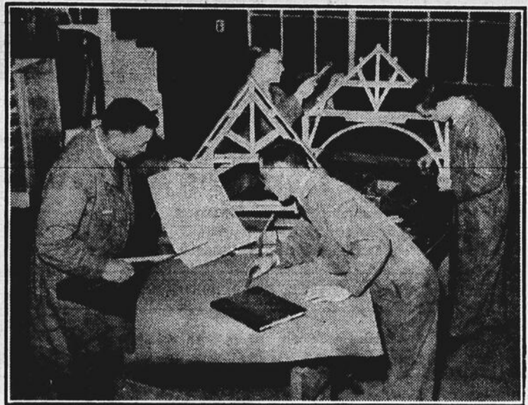
Coin de l'atelier de menuiserie et de charpenterie de l'Ecole Technique de Montréal. Au premier plan, on remarque un élève au travail sur une charpente de maison en miniature et le professeur, M. J. E. Gamache, donnant une démonstration sur la façon d'utiliser l'équerre.
