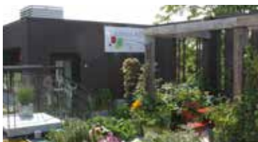
Toiture verte du Pavillon horticole écoresponsable où les végétaux à usage phytotechnologique sont mis en vedette
