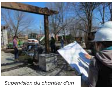
Remise à neuf d'un des murs verts du Pavillon horticole écoresponsable
