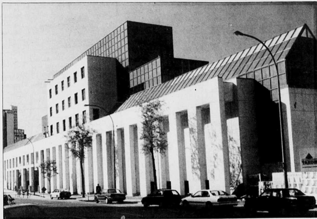
Le Musée d'art contemporain sous son nouveau toit, rue Jeanne-Mance, juxtaposant la Place des Arts. Ses nouveaux budgets sont moins resplendissants.
