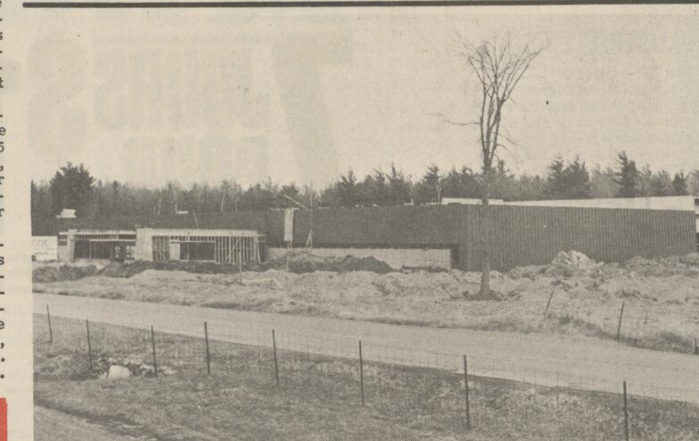
UN PREMIER OCCUPANT -- La nouvelle usine de Coyouette & Frères progresse rapidement et déjà on peut distinguer l'aspect définitif qu'offrira ce nouvel édifice. Les travaux de construction coûteront $400,000 à ce premier occupant du Parc industriel maskoutain. La firme fournira du travail régulier à quelque 140 personnes de Saint-Hyacinthe.
