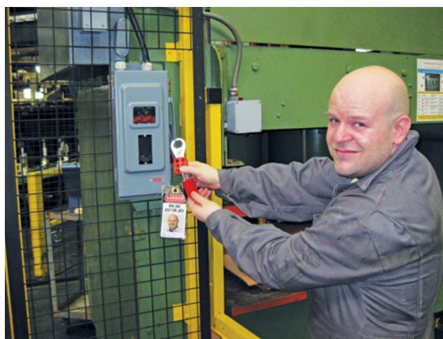
Cadenassage d'une installation électrique
