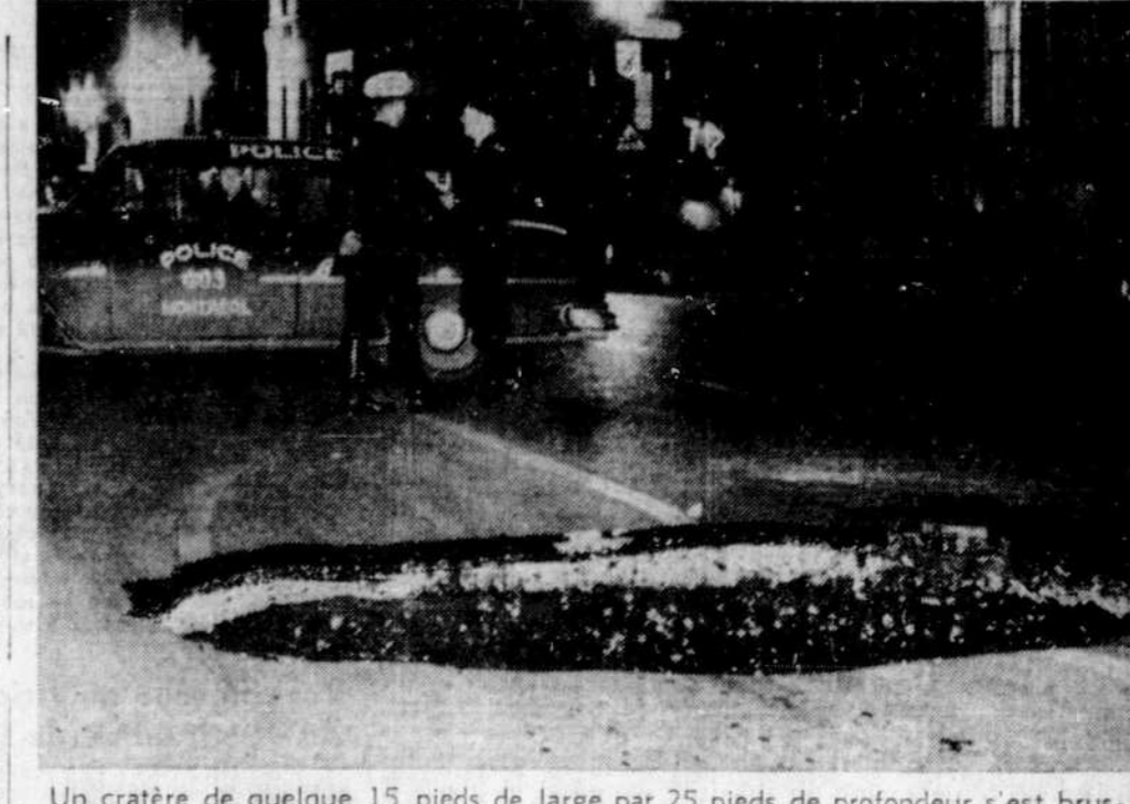
Un cratère de quelque 15 pieds de large par 25 pieds de profondeur s'est brusquement ouvert, hier soir, sur la rue Sherbrooke, à l'angle de la rue Victoria. L'incident, pour le moins inusité, s'est produit au beau milieu de la circulation dense de 5 heures. Un chauffeur privé qui attendait son patron prit sur lui de détourner la circulation, assisté d'étudiants de l'université McGill, en attendant l'arrivée de constables de la ville. Il semble qu'un courant d'eau ait rongé la terre sous le pavé, ce qui occasionna l'effondrement de la chaussée.
