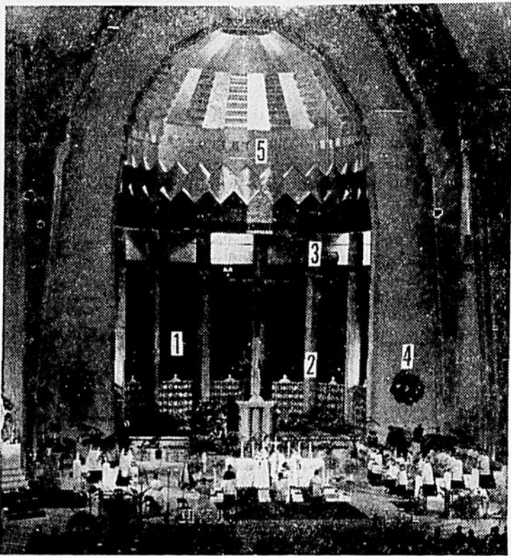
GROS TRAVAUX A L'ORATOIRE — Voici un aperçu de l'important programme de travaux projeté pour 1958 dans le choeur de la basilique de l'Oratoire Saint-Joseph du Mont-Royal: le fond de l'abside (1) qui recevra un fond de marbre rouge; la colonnade (2) qui sera recouverte de marbre vert; les chapiteaux (3) qui seront décorés de mosaïque d'or; le grand arc (4) illustrant la vie de saint Joseph, en mosaïque de céramique et d'or. La calotte (5) du choeur a été ornée de feuilles et de mosaïque d'or en 1957.
