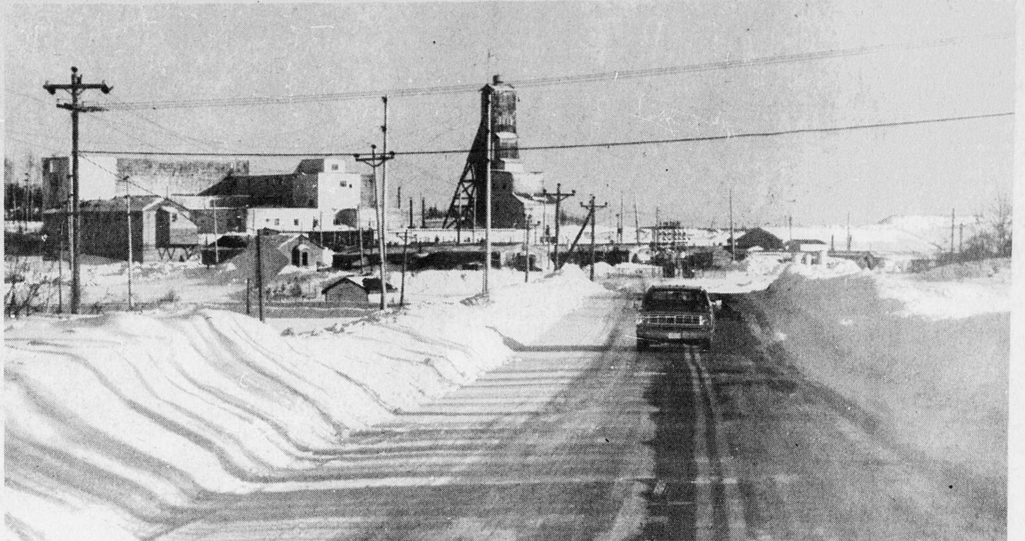
Les installations de la Cie Campbell à Chibougamau
