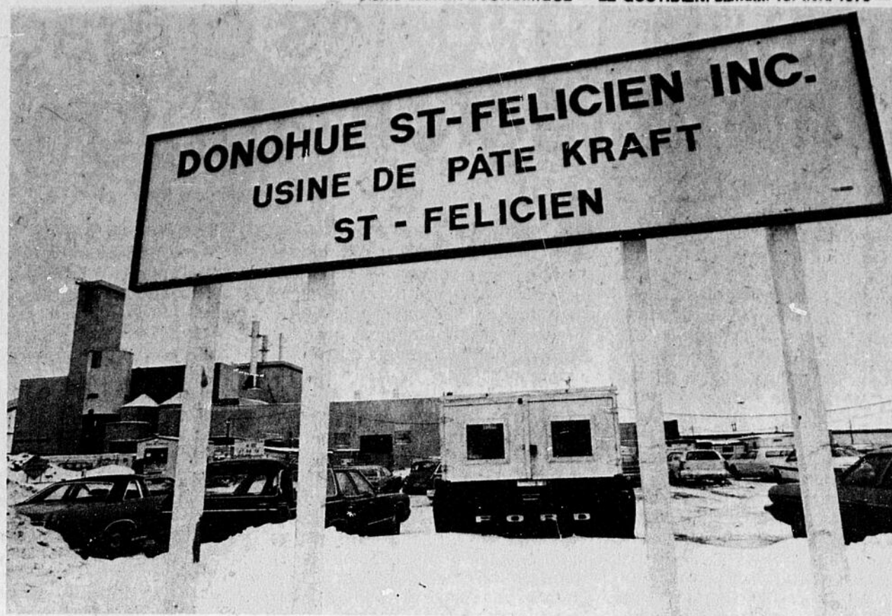
EN OPERATION — Les travaux d'aménagement de ce vaste complexe industriel doivent être terminés entre
