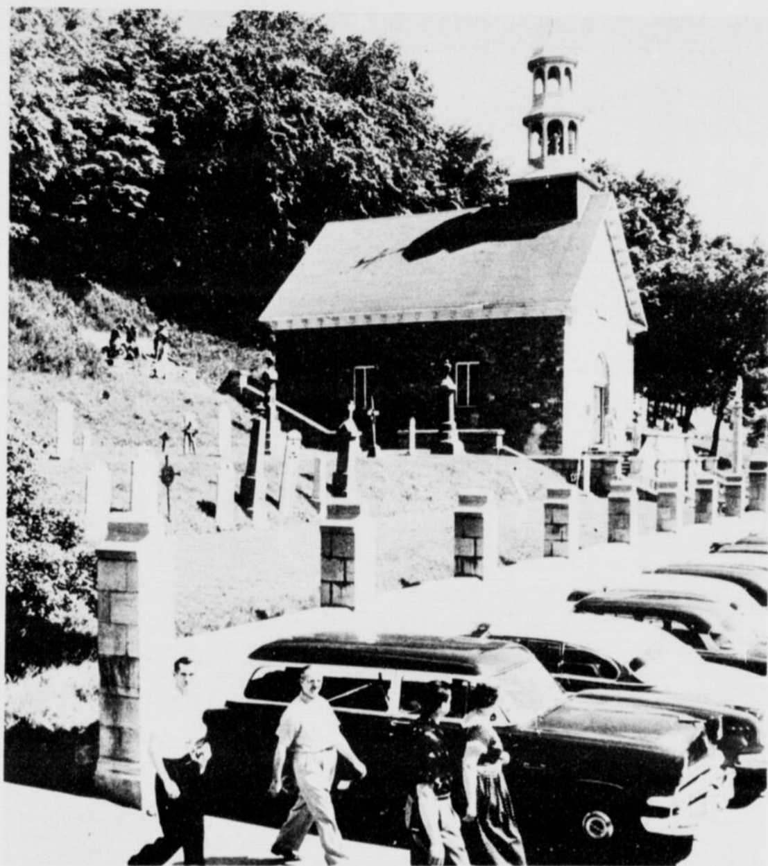
EN FLANC DE MONTAGNE , on visite avec émotion la chapelle-souvenir, bâtie sur l'emplacement et avec les pierres du temple de 1676 qui avait été restauré à diverses reprises. La toute première chapelle se dressait au bord du fleuve, et fut vite abandonnée, à cause du danger des marées et des glaces. En arrière de la chapelle-souvenir, on distingue l'une des stations du chemin de croix bâti à même la montagne dans un décor véritablement unique.
