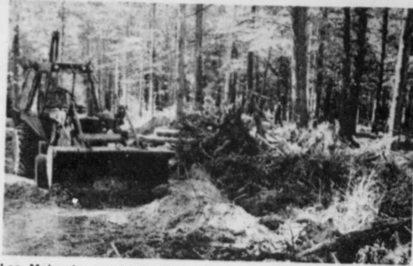
Les Mohawks ont interrompu, hier, vers midi, leurs travaux de déboisement.
