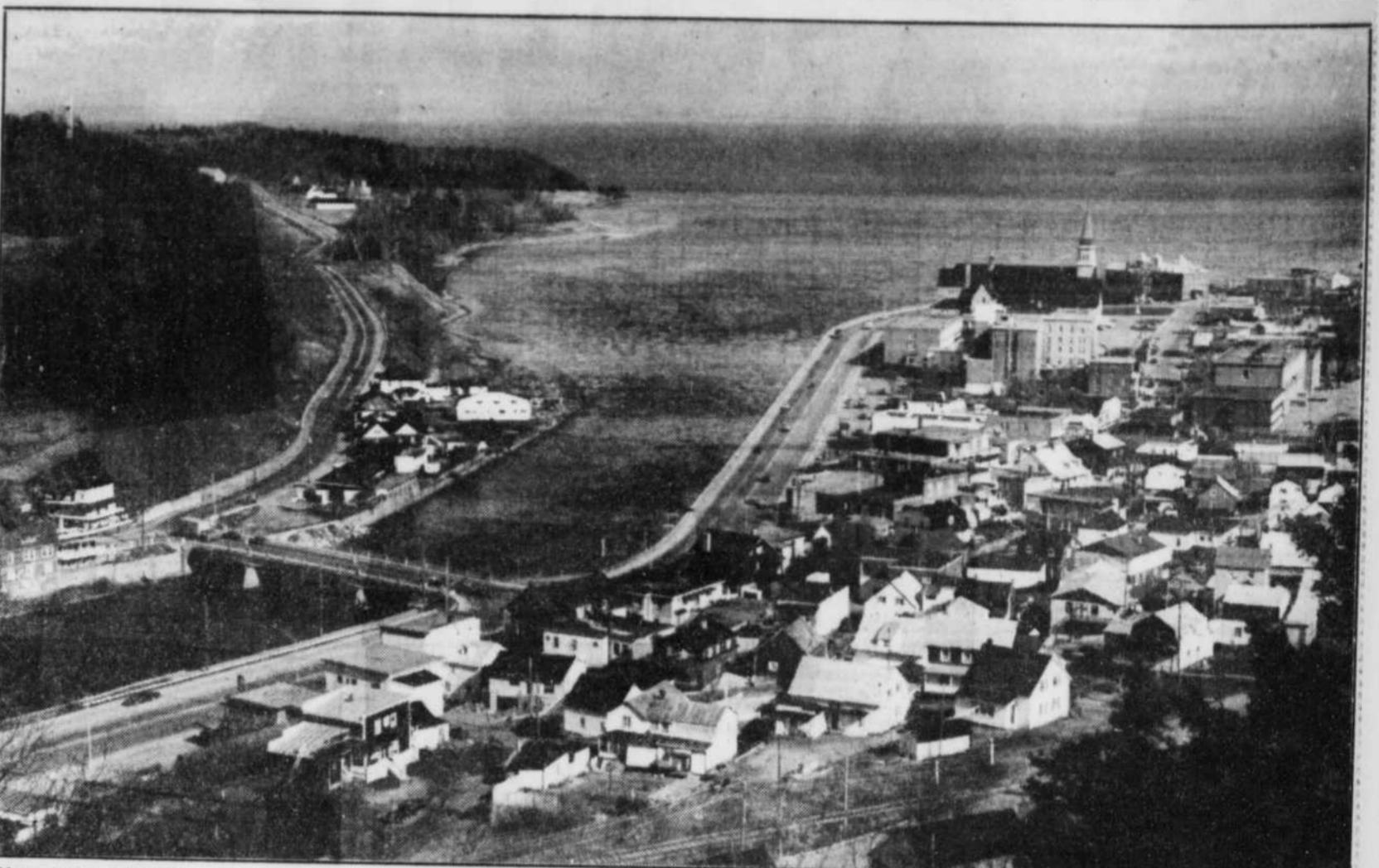
Vue de La Malbaie.
