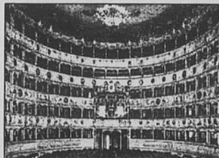
L'interno del teatro andato completamente distrutto dalle fiamme.
