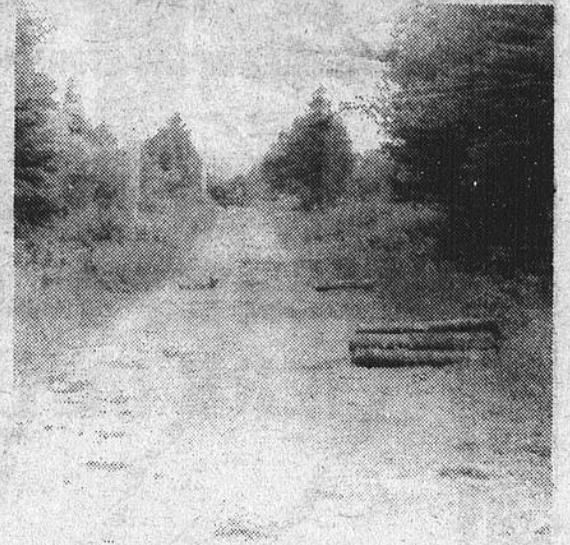
C'est une rue solide et construite pour être utilisée par les camions poids lourds qui fera bientôt son apparition près de Rotobec. Après avoir coupé les arbres pour donner l'emprise nécessaire à la rue, on enlèvera les matériaux faibles qui s'y trouvent et on étendra de la gravelle.
