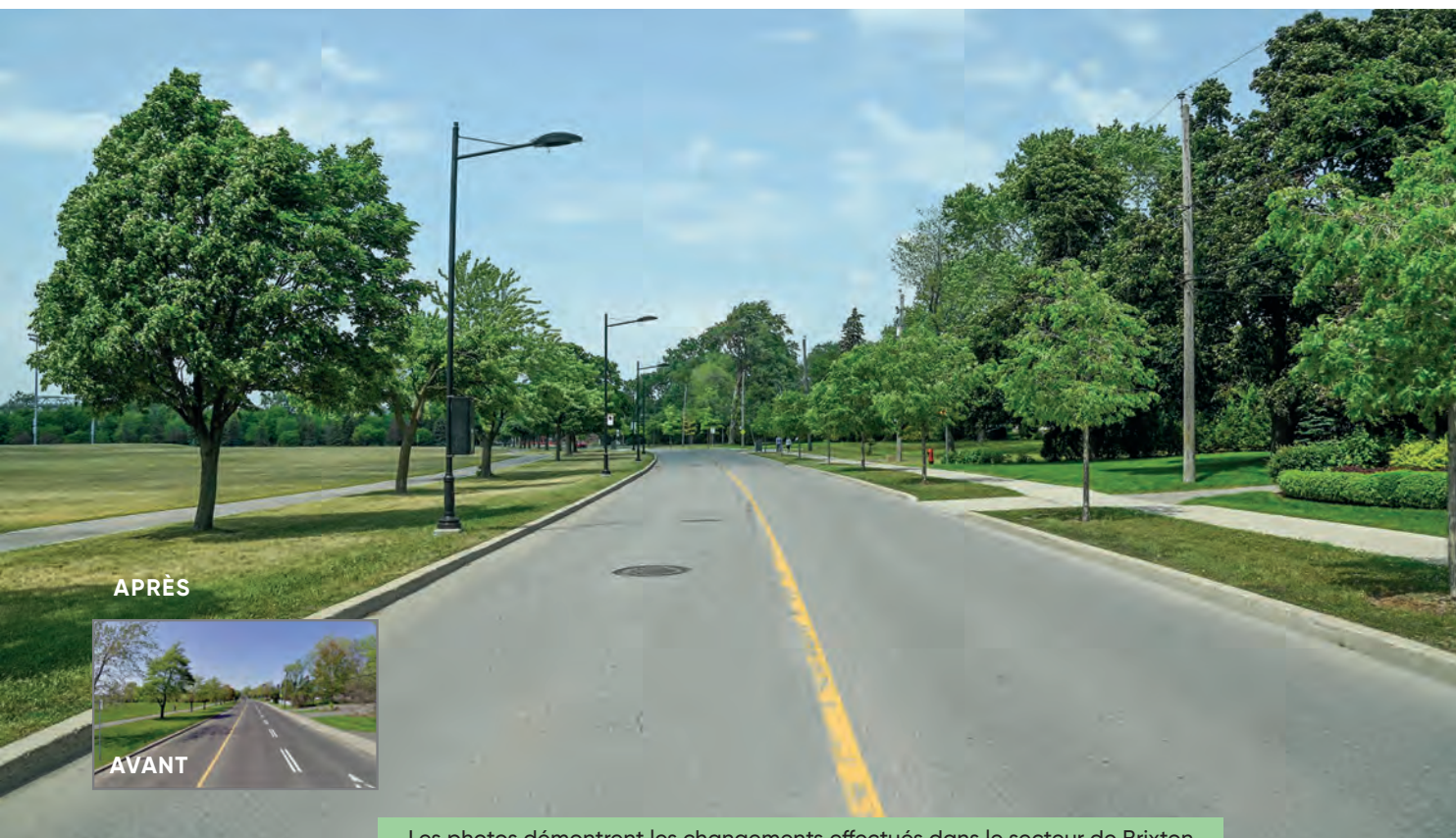
Les photos démontrent les changements effectués dans le secteur de Brixton.
